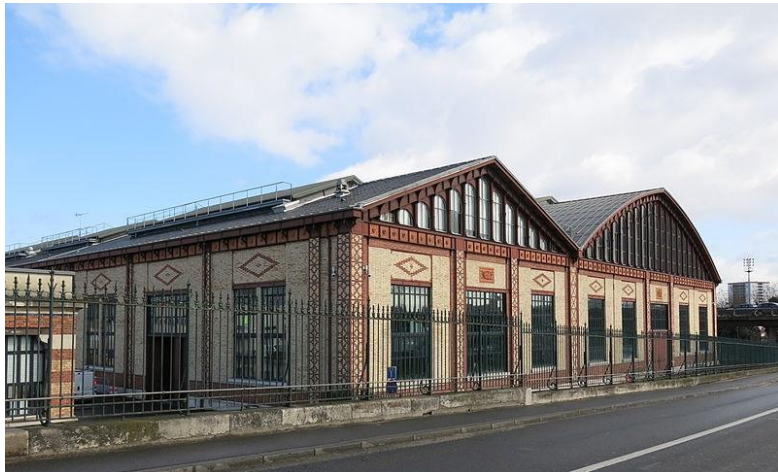
Usine élévatrice des eaux - Colombes
