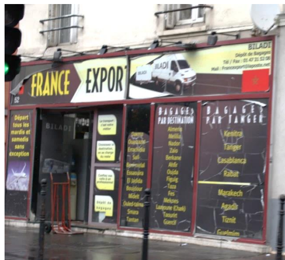
Enseignes en mauvais état, commune de Clichy-la-Garenne
