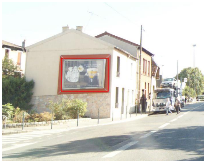
Publicité murale d'une surface de 13.90m 2 (encadrement compris), commune de Villeneuve-la-Garenne
