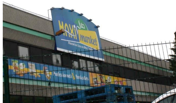
Enseigne dépassant le haut du mur, commune d'Argenteuil
