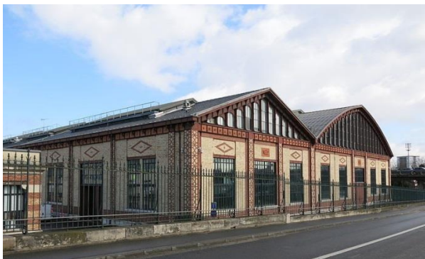
Usine élévatrice des eaux – Colombes
