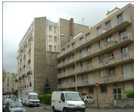
rue Morillon, non respect des alignements sur rue des années 70-80
